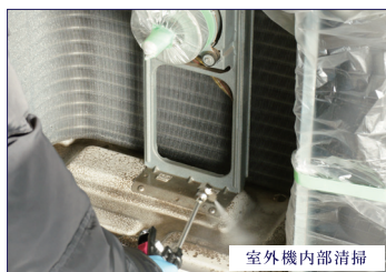
室外機内部清掃
